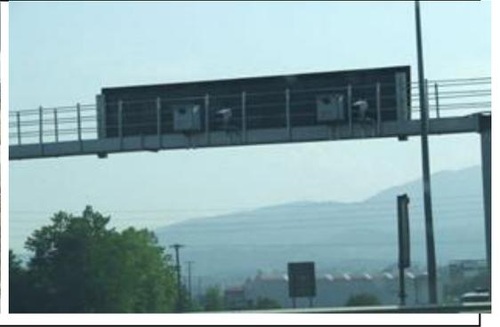
Los **Autovelox fijos** (foto 3), son de tipo láser transversal (**indetectables por ningún sistema**) y, por tanto, únicamente serán anunciados con bastante anticipación mediante el avisador GPS.
